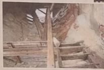
Foto oben: Die Turmhaube (rechts) ist vom Turm (links) heruntergenommen worden und soll restauriert werden. Auch diese Holztreppe spielt eine Rolle im Kinderbuch.
